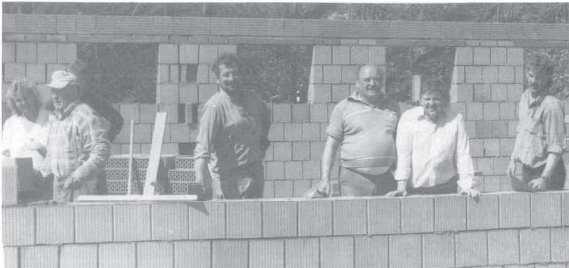
Mit dem Bau des Tennisheims wurde bereits begonnen
